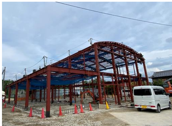
建設中の新体育室
